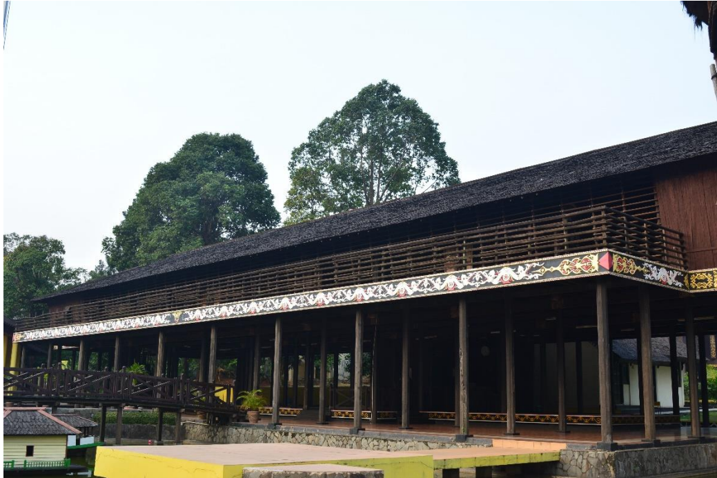
Rumah Panjang Anjungan Kalimantan Barat TMII
